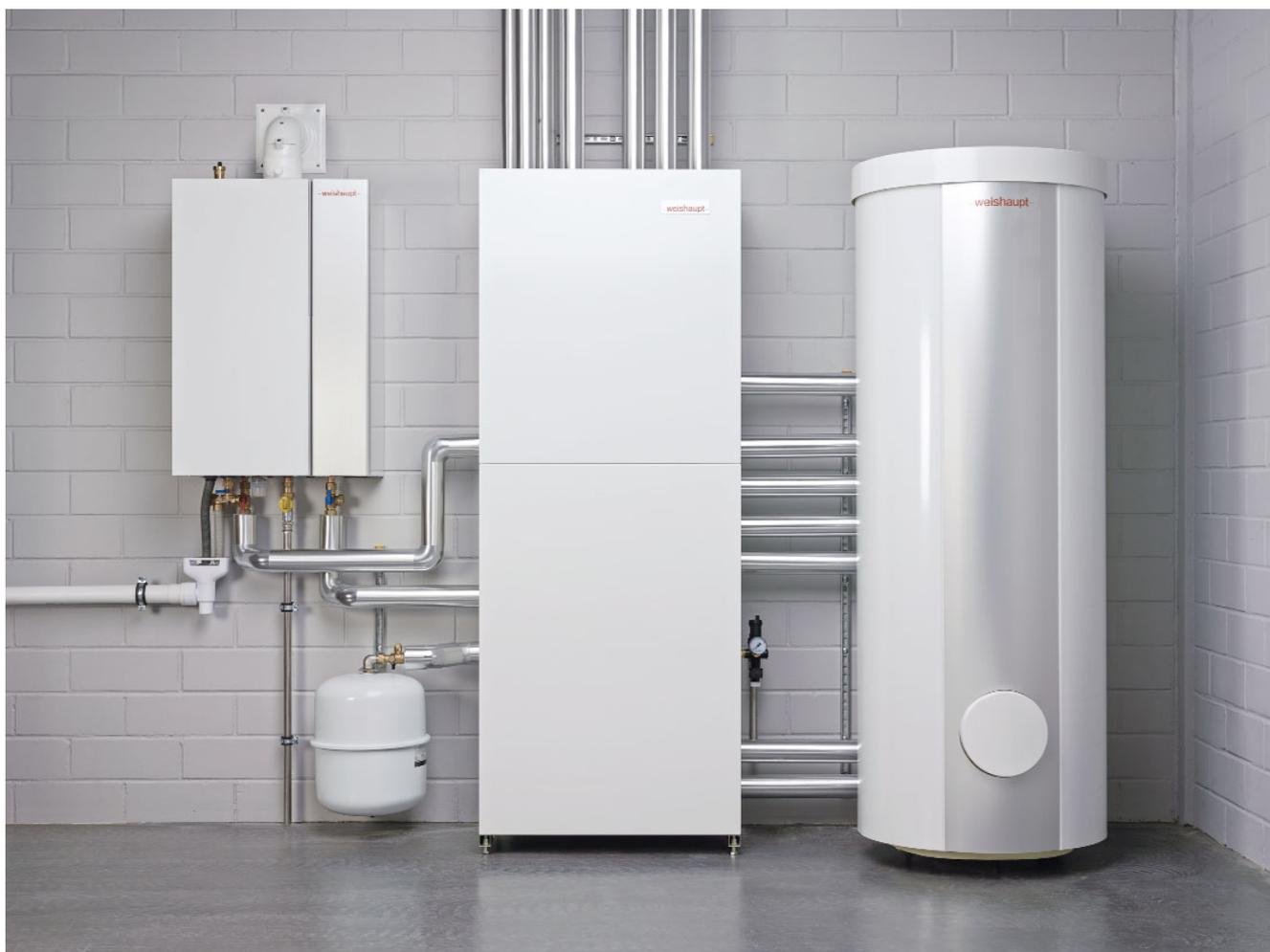
Exemple d'installation avec une chaudière à condensation gaz
